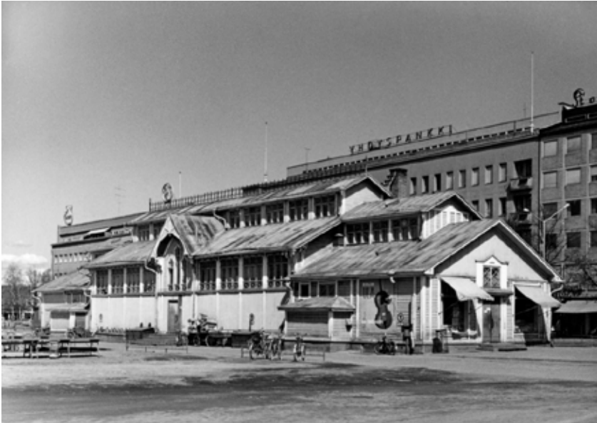
Kuva 6. Vanha kauppahalli kuvattuna arviolta 1950- tai 1960-luvulla. Siltakadun varren 1930–1940-luvuilta olevat liikerakennukset seisovat jo nykyisillä paikoillaan. Kauppahallia ympäröivä toriympäristö sen sijaan pöytineen ja sorapintoineen näyttää huomattavan erilaiselta nykyiseen verrattuna. (Kuva: Pohjois-Karjalan museo)
